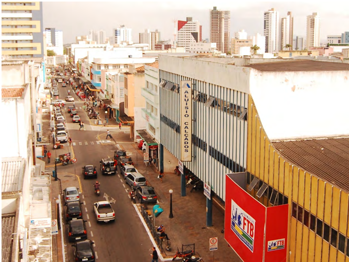
Figura 66 – Edificação da Aluísio Calçados atualmente em desuso.
