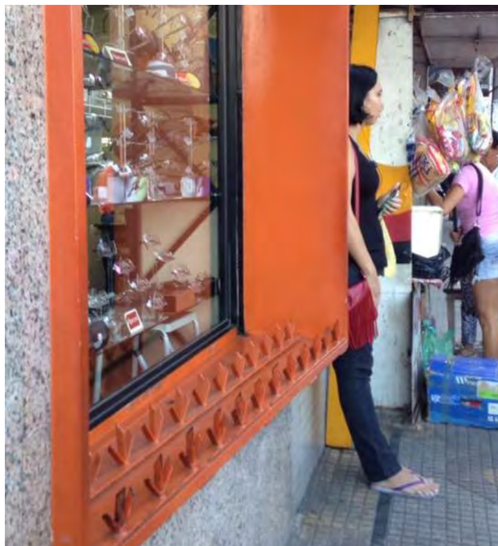
Figura 18 - Parede como apoio na Rua Peregrino Carvalho, em Campina Grande –PB.
