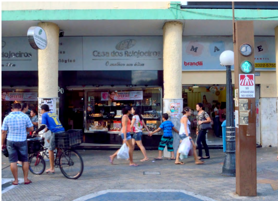
Figura 15 - Fachada térreo na rua Maciel Pinheiro, Campina Grande –PB.
